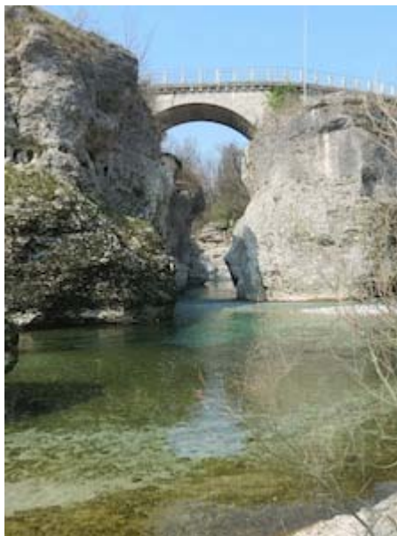
Figura 5: Morfotipi in corrispondenza del Ponte Romano sul Fiume Natisone (Premariacco)
