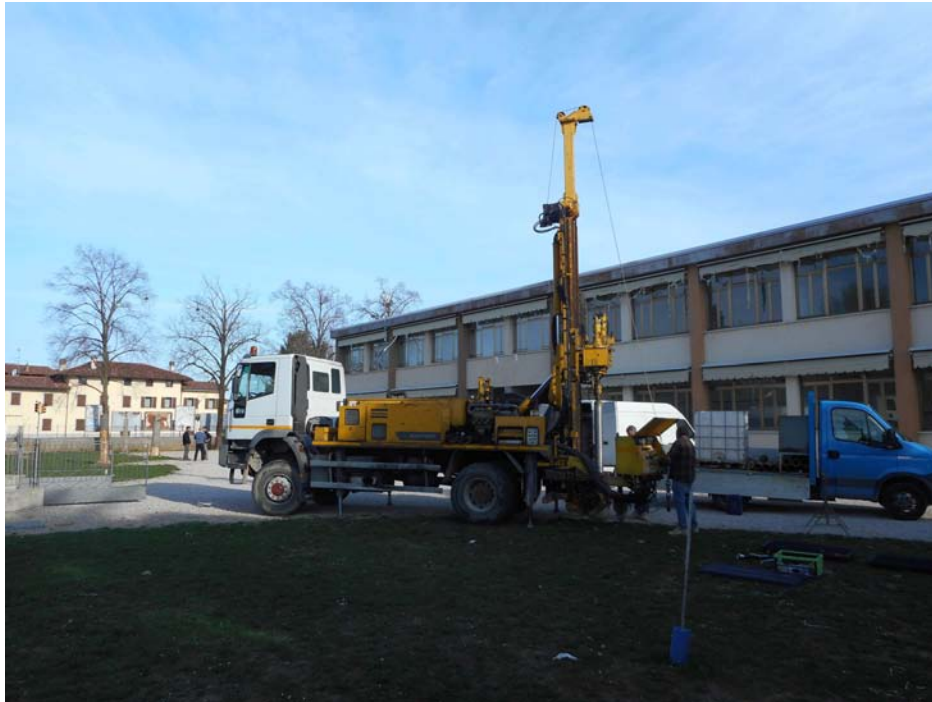
Sondaggio S1: posizionamento delle attrezzature.
