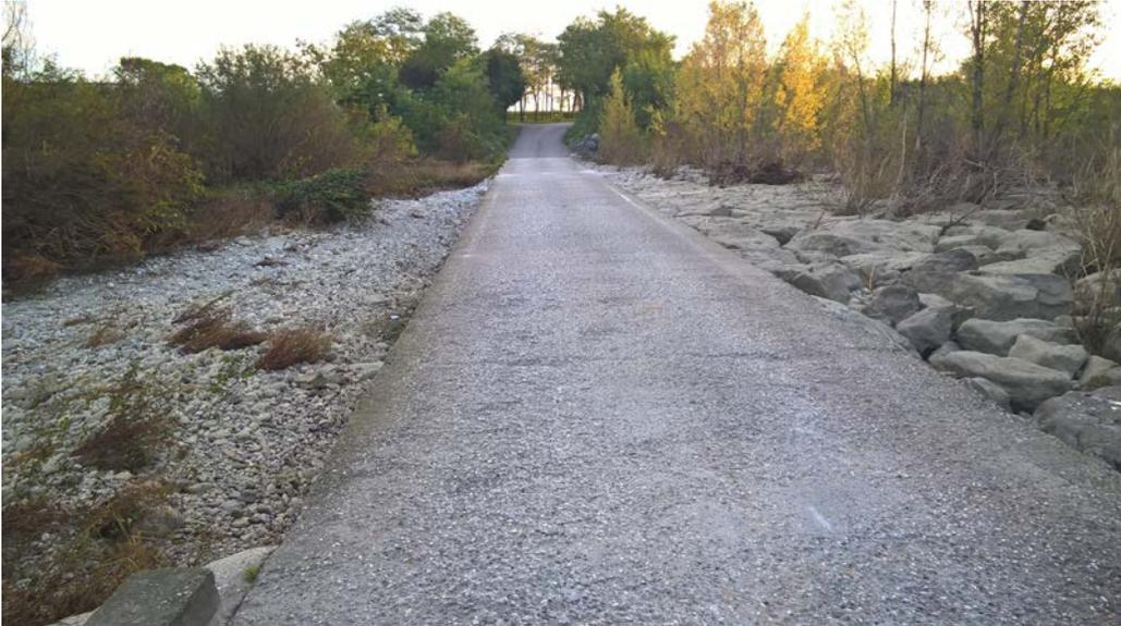
Dettaglio del guado nel quale si può osservare come la superficie del fondo stradale necessita di un trattamento per la conservazione dello stesso e per migliorarne l'aderenza.
