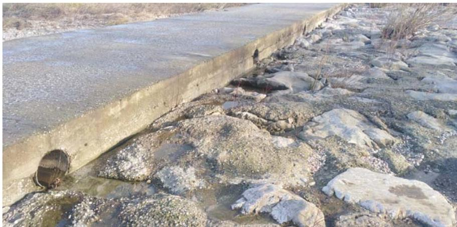
*Figura 3 – I tubi di magra che sottopassano il guado in calcestruzzo. A valle la scogliera esistente di protezione*
